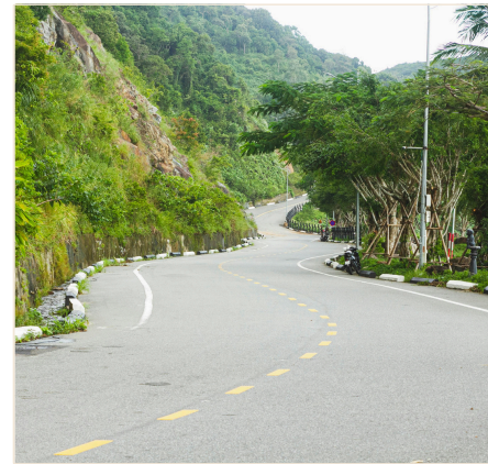
LA ROUTE la nuit, l'autoroute, les passages à niveau, les intempéries...
